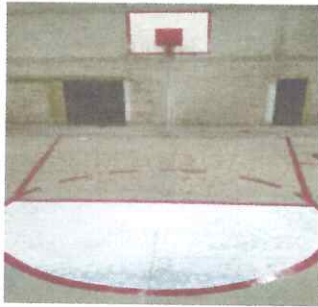
• Pintura en piso y tableros
